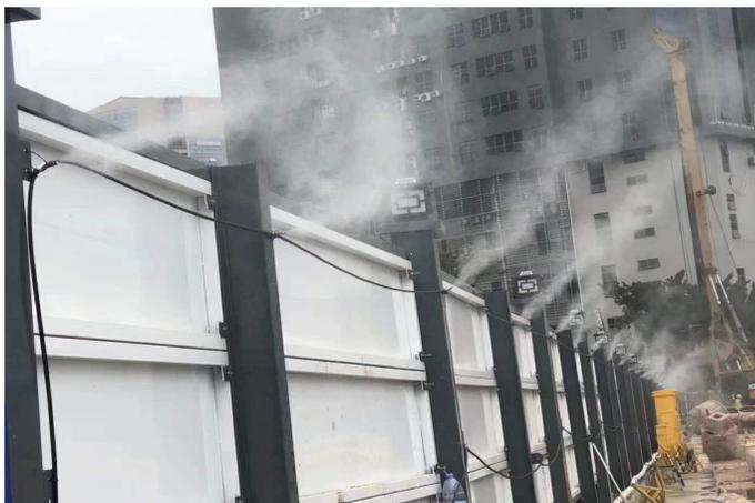
围挡喷淋朝向施工现场
